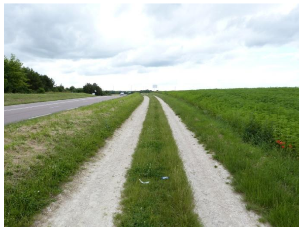
Accotements longeant la RD 619
