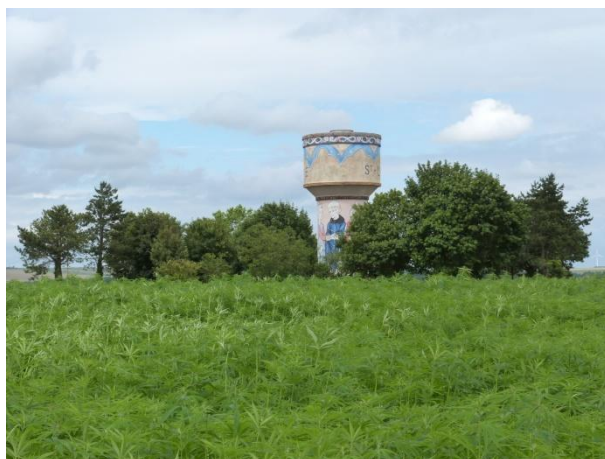
Réservoir sur tour de Saint-Lyé
